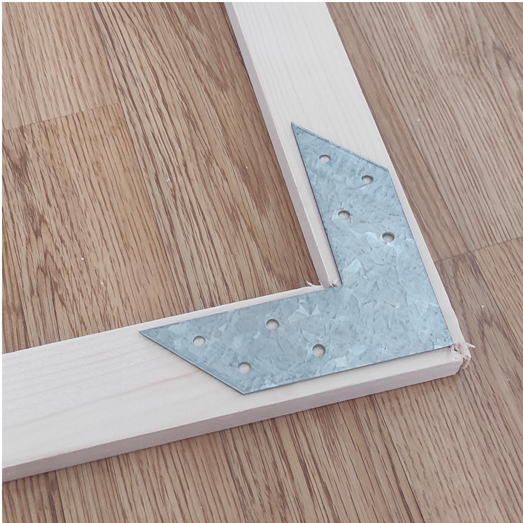
Puidust tugiraami valmistamine. Pildil on veel kinnitamata nurk.
