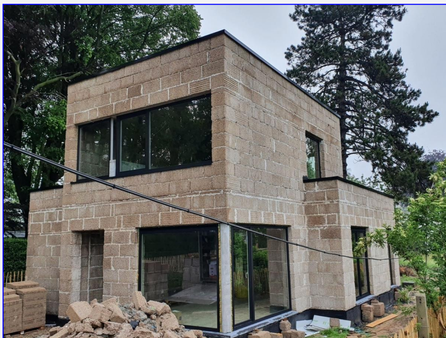
Joonis 21: Täisplokkidest ehitatud hoone (Hempro)
