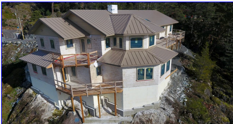
Joonis 23: Kahekorruseline maja, mis on ehitatud Just Biofiber kanepilubjaplokkidest (Bloomberg)
