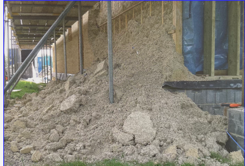
Joonis 19: Kanepilubjast seina kokkukukkumine (The Hempcrete Book)
