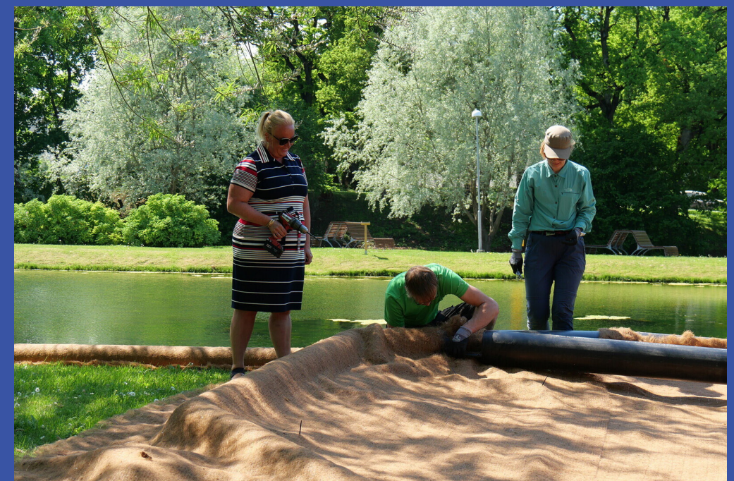
Illustratsioonid 51–52. Ujuvsaarte ehitamine. Allikas: ERR.
