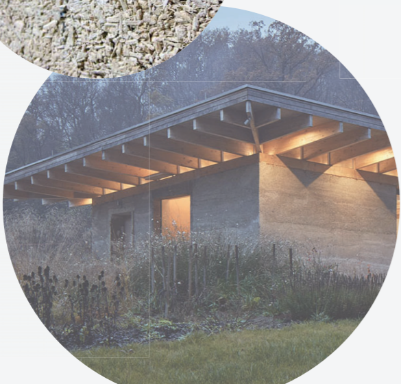
House LO Arhitekt Lina Bellovičová
